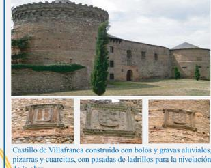
Castillo de Villafranca construido con bolos y gravas aluviales, pizarras y cuarcitas, con pasadas de ladrillos para la nivelación de la obra.
