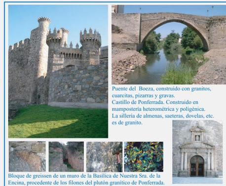
Puente del Boeza, construido con granitos, cuarcitas, pizarras y gravas. Castillo de Ponferrada. Construido en mampostería heterométrica y poligénica. La sillaría de almenas, saeteras, dovelas, etc. es de granito.
